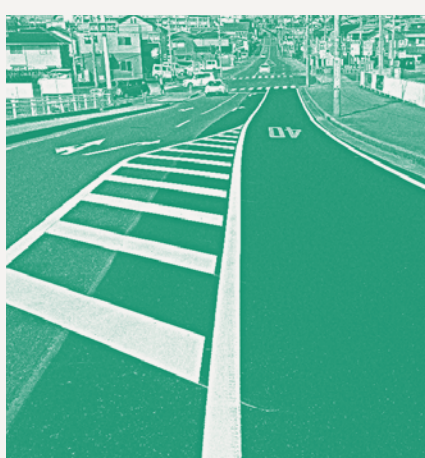
施工後 静岡県豊田市の市道
