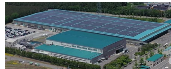
酒田工場の太陽光発電設備
