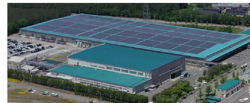
酒田工場の太陽光発電設備
