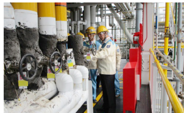
和歌山工場の高圧ガス保安検査
