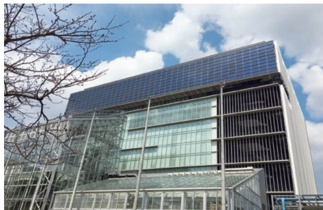
和歌山研究所に設置された太陽光発電設備
