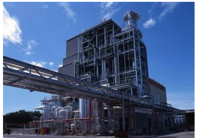
ファティケミカル(マレーシア)の高級アルコール製造プラント
