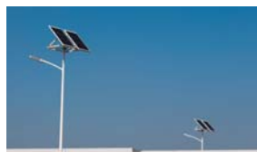
新たに導入した太陽光発電式街灯
