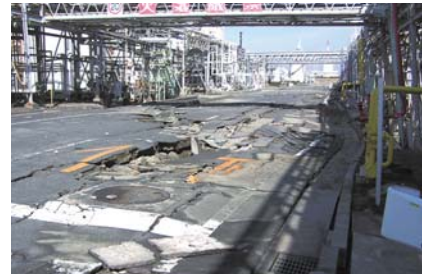
液状化の被害を受けた鹿島工場
