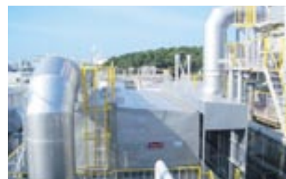
蓄熱式脱臭炉
