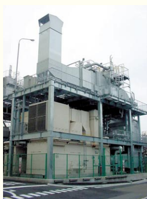
川崎工場のコ・ジェネレーション設備
