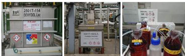
作業所 GHS 表示の例 (左から貯蔵タンク、原料受入れ口、分析室)
