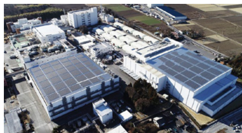
栃木工場の太陽光発電設備
