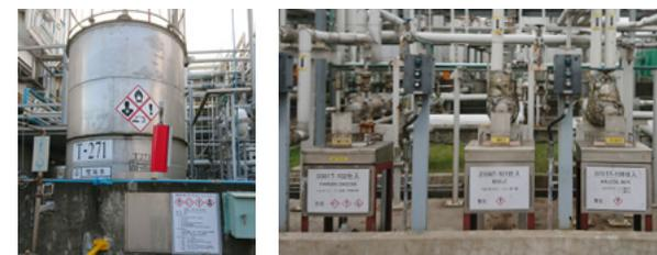
貯蔵タンクGHS表示(例) 原料受入れ口の作業場GHS表示(例)
