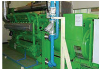
CDMの対象のコジェネレーション設備
