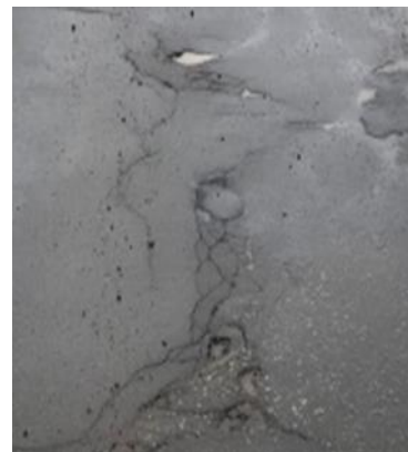
図1. ポットホールの例
