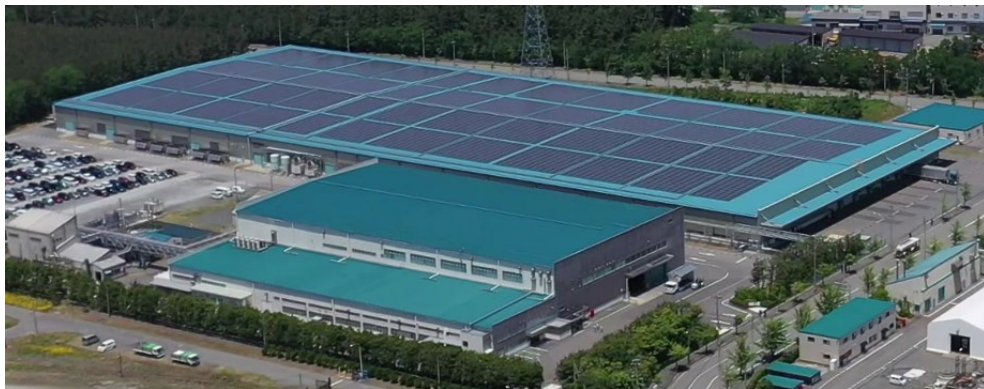
酒田工場の生産棟に設置された太陽光発電設備
