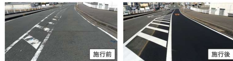
廃PETを用いた高耐久アスファルト改質剤が 自治体として初めて静岡県磐田市で採用
