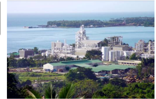
フィリピンの油脂アルコール製造設備
