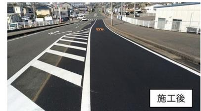
廃PETを用いた高耐久アスファルト改質剤が自治体として初めて静岡県磐田市で採用
