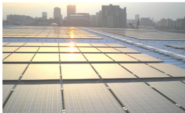
ロジスティクスセンターの屋上に設置された太陽光発電用パネル
