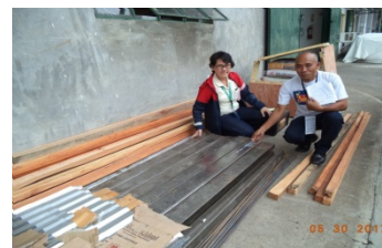
小学校の修繕（フィリピン）
