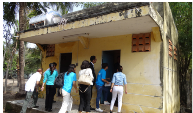
実際に幼稚園で使用しているトイレ
